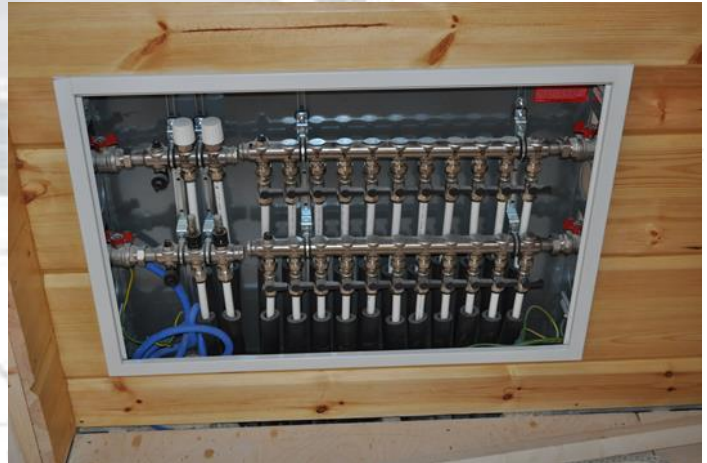
Шкаф распределительный встроенный
