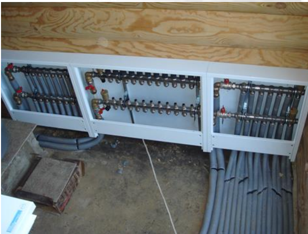
Шкаф распределительный накладной
