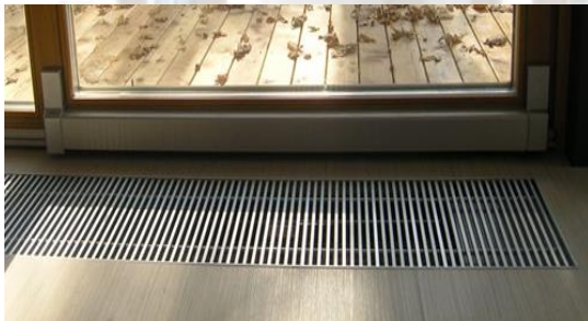
Рисунок 3. Конвектор встроенный «MINIB»
