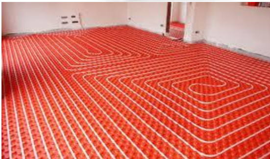
Схема укладки тёплого пола
