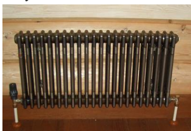
Рисунок 3 Нижнее боковое подключение, радиатор «IRSAP»
